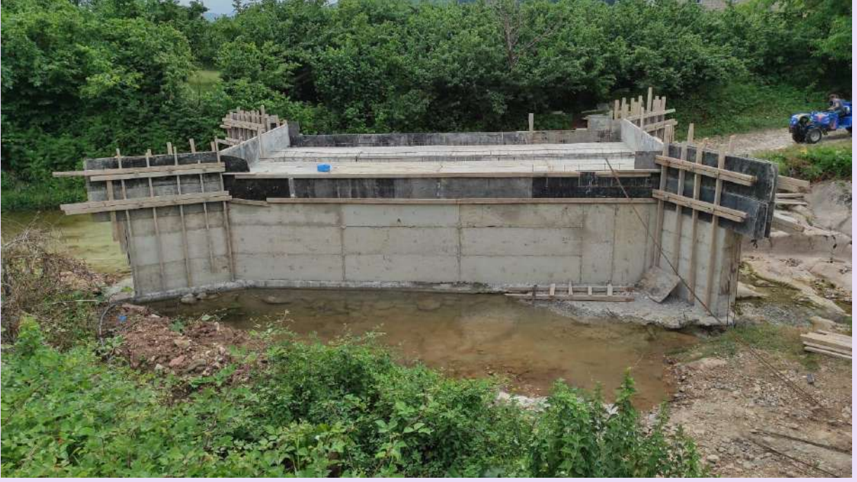
5. İlçemiz Cevizdere Mahallesiinde yapımı tamamlanan ‘‘Yöresel Ürün Üretim Atölyesi ve Aşevinin’’ yolu ve istinad duvarı yapılarak hizmete açılmıştır.
