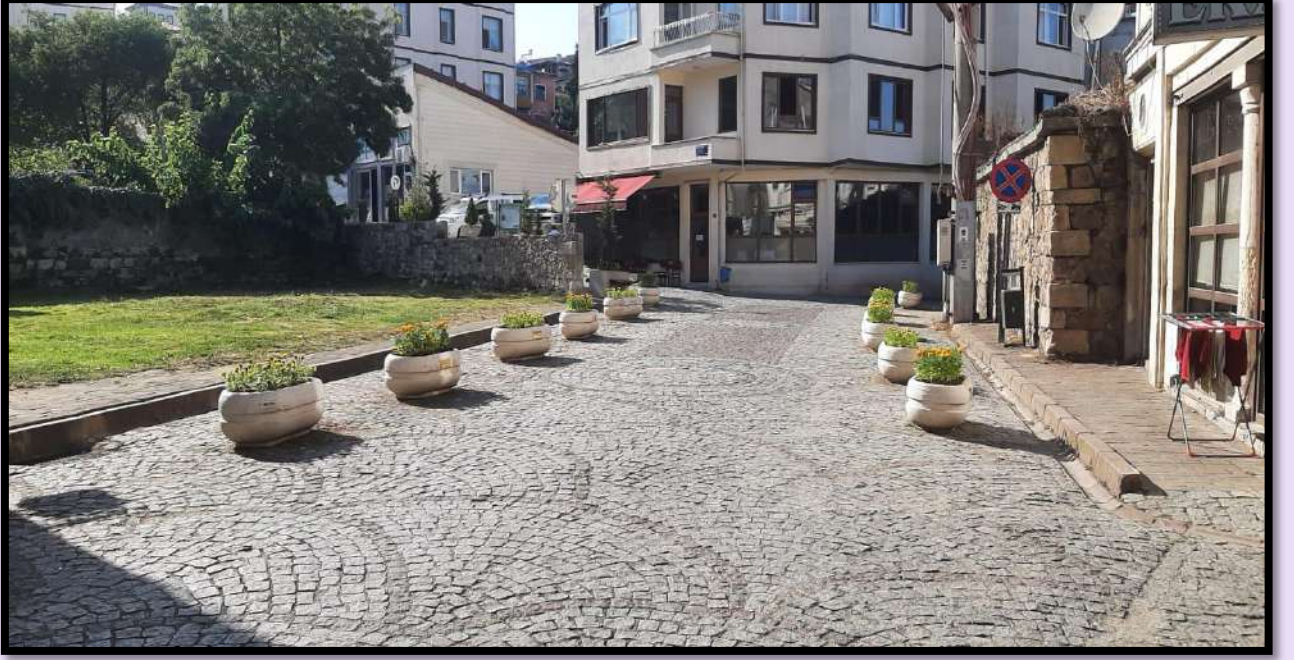
(Kaledere Mahallesi Kadılar çevre düzenlenmesi yapımı)
