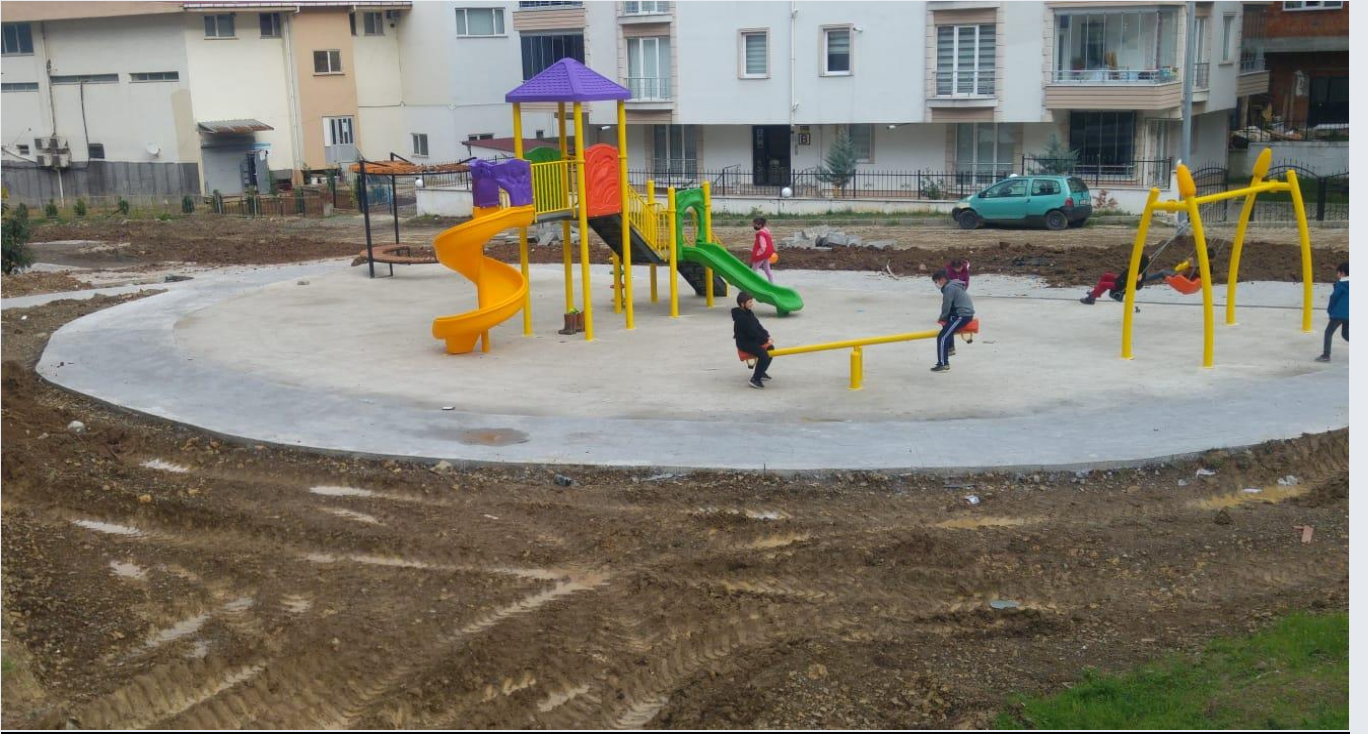
Atatürk Mahallesi Gültepe Sokak Çocuk Parkı Yapımı
