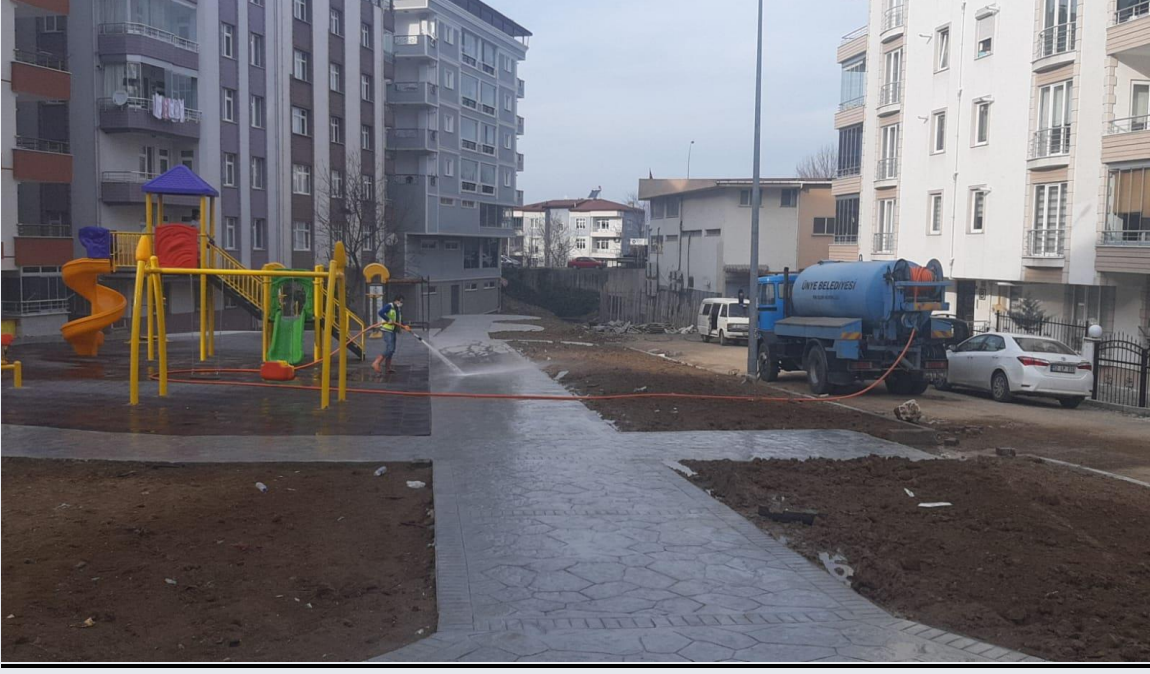
Atatürk Mahallesi Gültepe Sokak Çocuk Parkı Peyzaj Düzenlemesi
