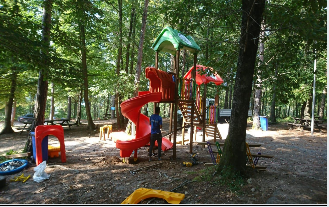
Asarkaya Kent Ormanına Çocuk Parkı Yapımı
