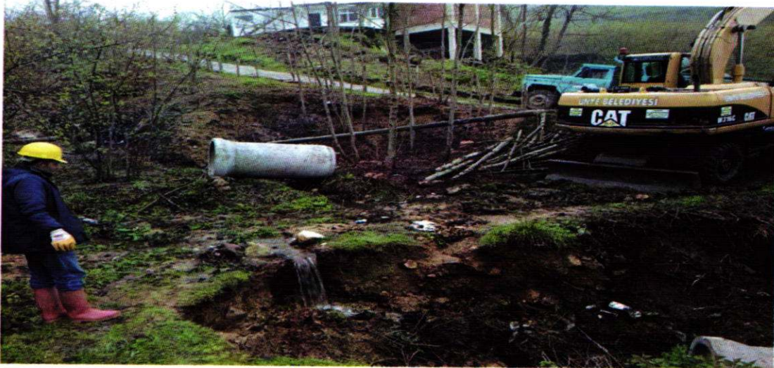
SARİHALİL MAHALLESİ YALAK MEVKİİ YAĞMURSUYU HAT ÇALIŞMASI
