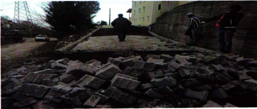
ÇATALPINAR MAHALLESİ ORDULULAR MEVKİİ YOL TESVİYE ÇALIŞMASI
